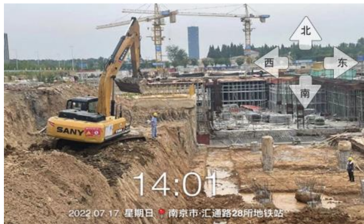
洞外开挖、降水
